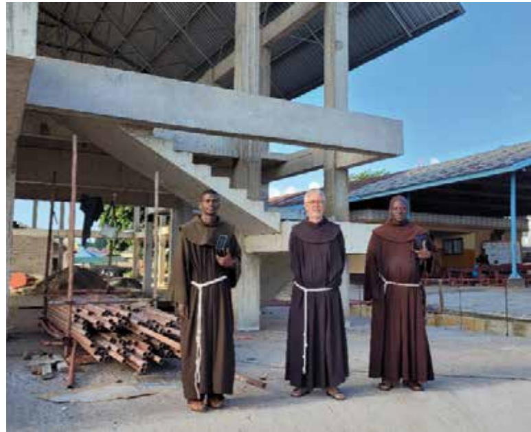
fr. Oscar con i confratelli fr. Jean de Dieu e fr. Fideli. Si possono vedere la nuova chiesa in costruzione e a lato la vecchia chiesa.
